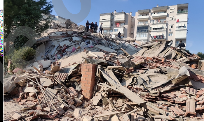
Depremler sonucu yıkılan binalar
